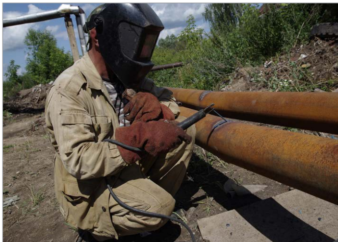
Замена тепловых сетей в с. Угодичи/
