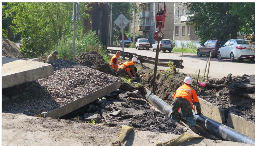
Ремонт теплотрассы в г. Ростове.
